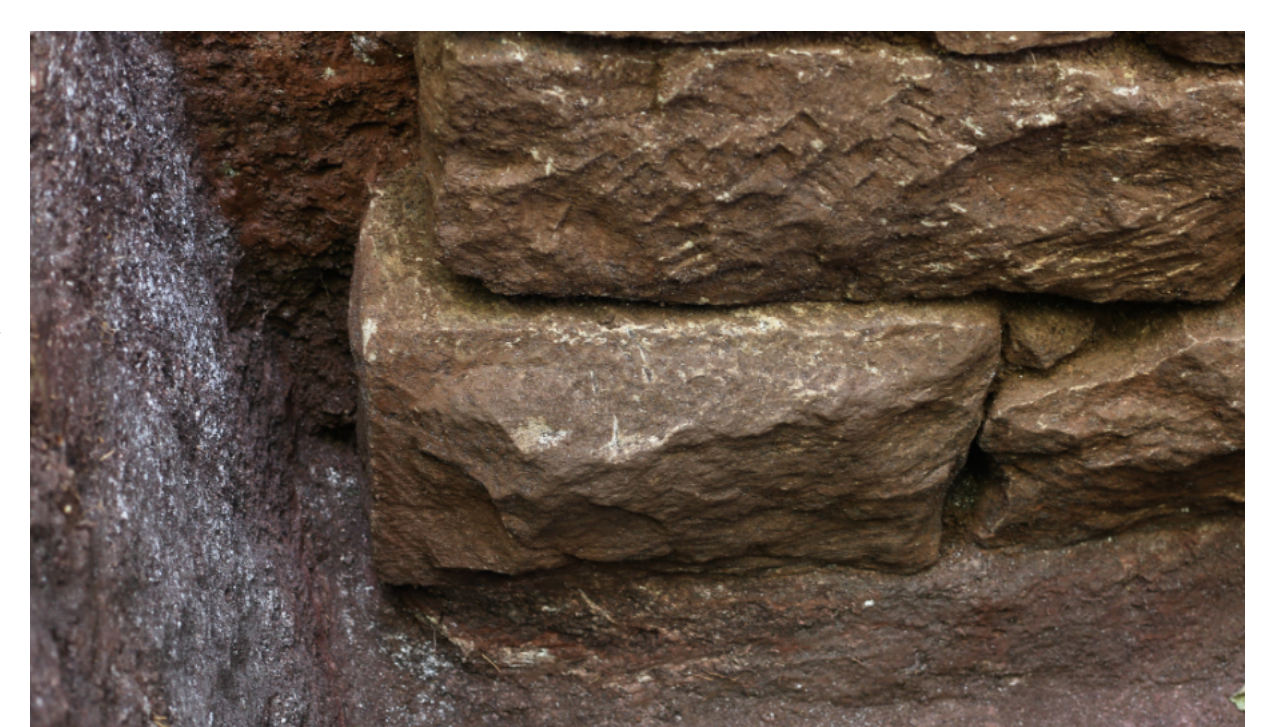
Eine Überraschung erwartete die Ausgräber bei der Untersuchung des Eckfundaments. In die unterste Lage war ein bossierter Sandsteinquader eingesetzt worden. Solche Mauersteine waren sehr aufwendig zu fertigen. In Waldaschaff wurde, vielleicht aus Kostengründen, bald nach Baubeginn auf einen solchen Dekor verzichtet.
