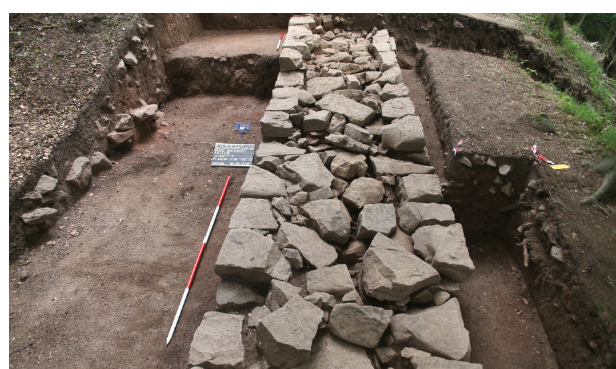
Die doppelschalige Ringmauer besaß im Sockelbereich eine Breite von bis zu zwei Metern. Sie bestand aus mächtigen, in Kalkmörtel gesetzten Sandsteinen.
