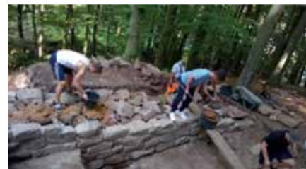
Arbeiten zur Wiederherstellung der Mauern. Foto: Wolfgang Beyer
